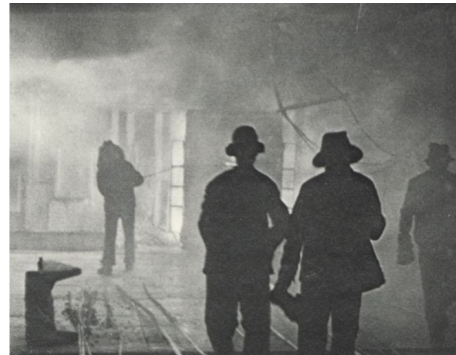
Figure 7. Antoni Wieczorek, Robotnicy opuszczają karbidownię (Workers Leaving a Calcium Carbide Plant), Nowości Fotograficzne no. 20 (1938), 32
